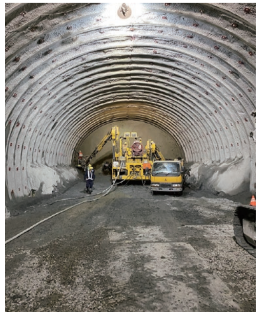
▶国道306号線バイパス トンネル工事
